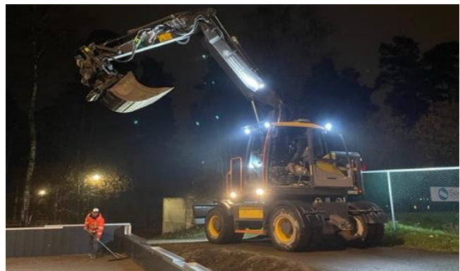
Samme kveld samlet Eirik Hagen en dugnadsgjeng for å fylle sand over betongen i alle modulene.
