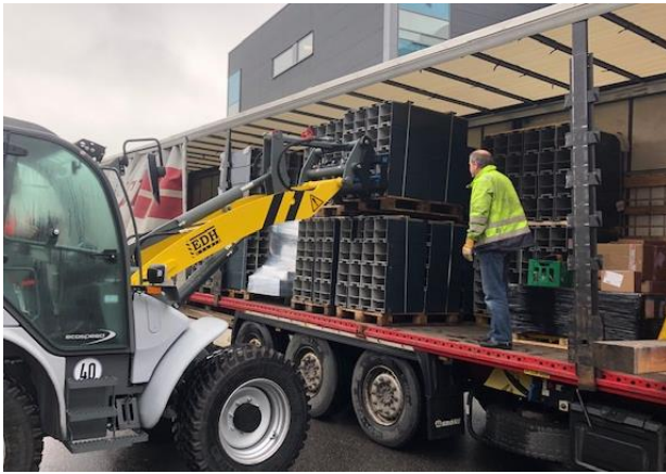
Tirsdag 1. november kom alle veggmodulene.
