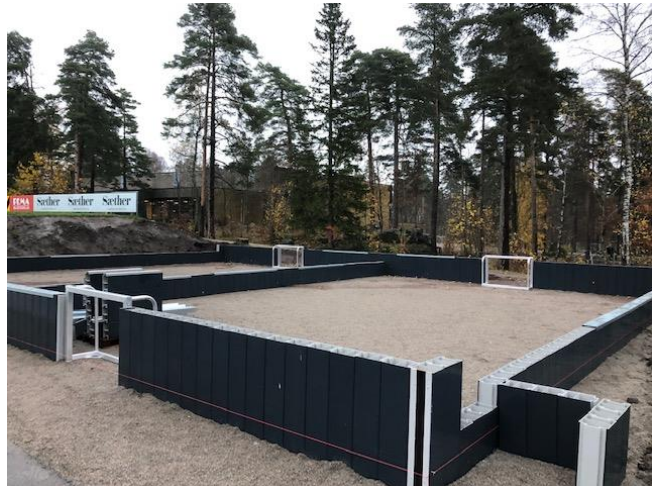
4. november var alle veggmodulene sirlig satt opp.
